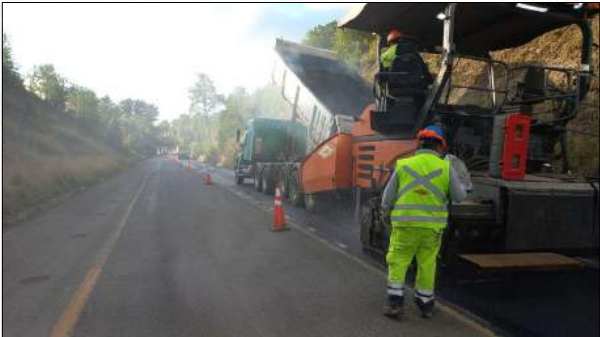
Obras conservación vial Ruta T-981-U
