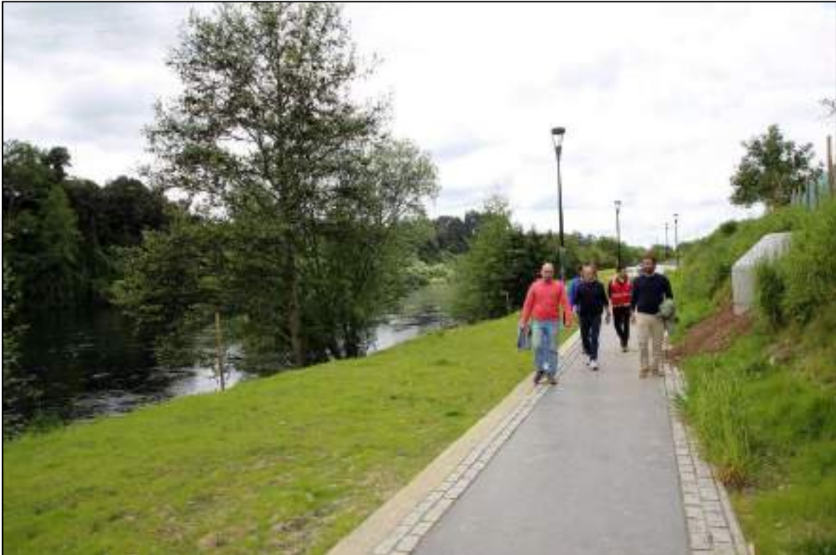
Obra: “Construcción Infraestructura para navegación turística Río Bueno, Provincia del Ranco, Región de Los Ríos”
